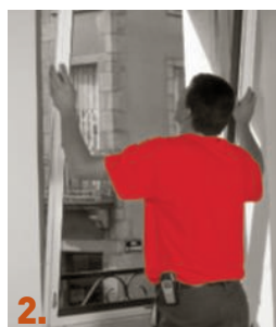
2. Mise en place de la nouvelle menuiserie.
