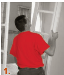
1. Dégondage des ouvrants.
